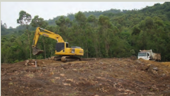
Vista parcial das obras na área II – Ex-Patrimônio (Siderópolis, SC).
